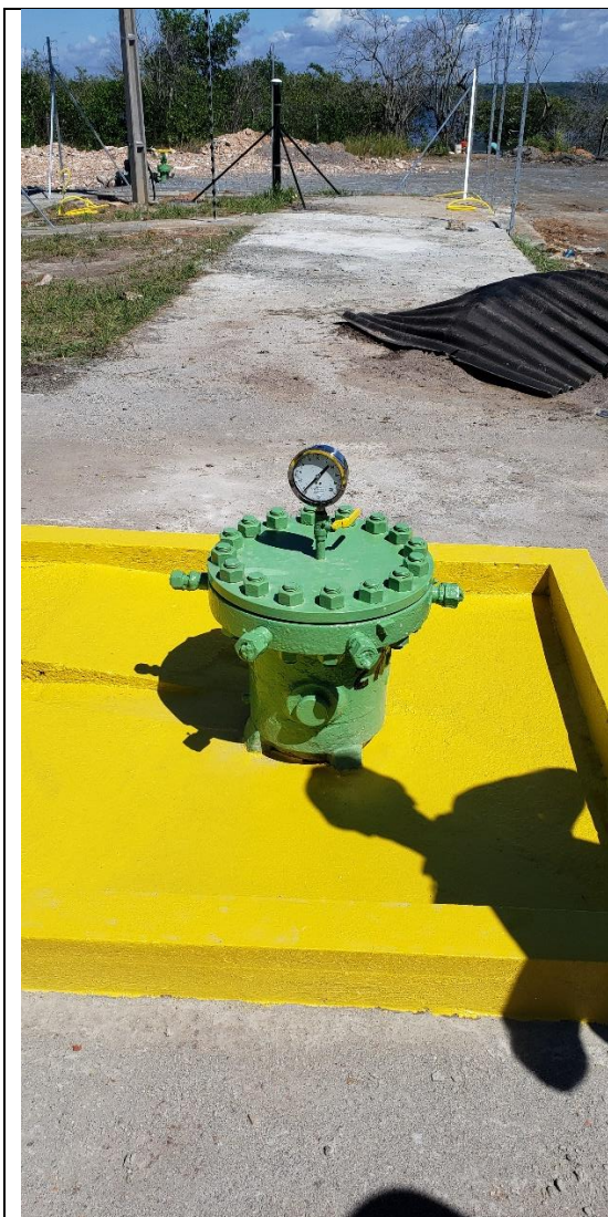
Poço 27 (comunicado com poço 7) – manômetro de controle marcando pressão nula
